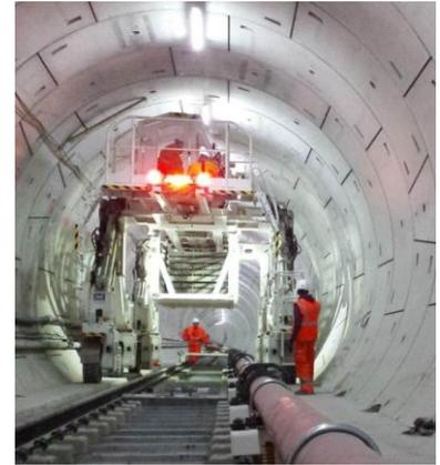
Pour Crossrail, TSO et ses partenaires ont réalisé l'installation des voies, de la caténaire et services électromécaniques. TSO a notamment mise en place cinq types de voies ferroviaires différentes et mobilisé des engins de travaux innovants : train béton, portiques multi usages...
